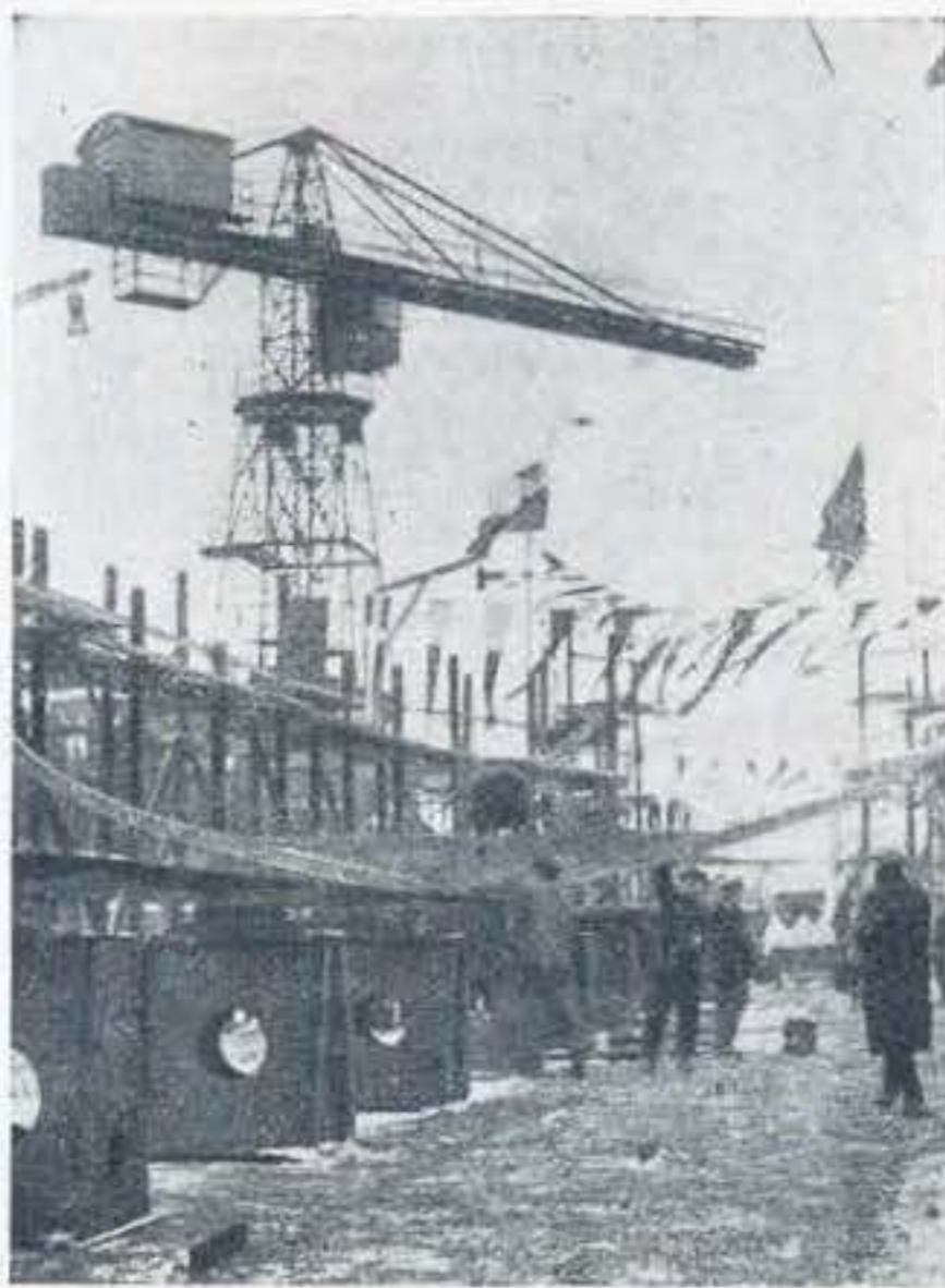
Montowanie dwóch nowych statków „Żegluga Polskiej” w Stoczni Gdańskiej.
