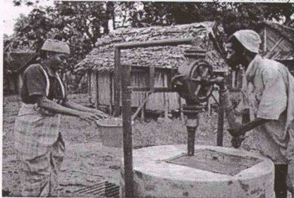
"well" Nowoczesne ujęcie wody na wsi. W tyle typowy wiejski dom.
